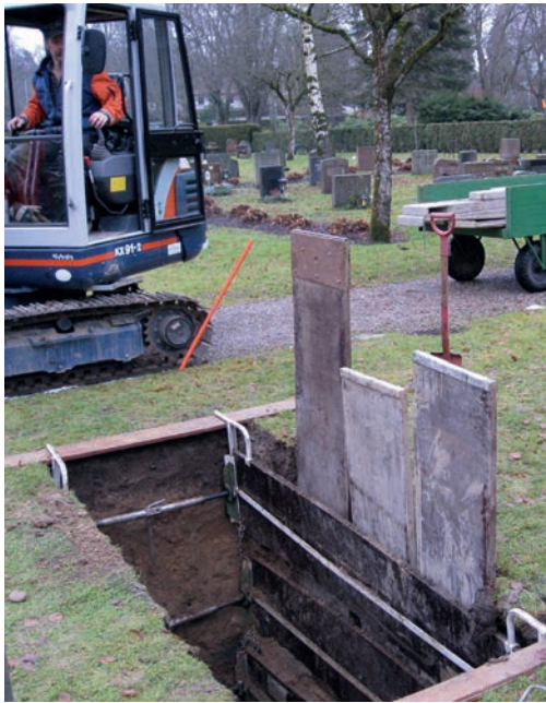
AB Orax traditionella stämplingslämmar förstärkta med stående spont.
