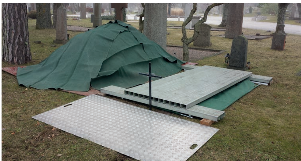
Ett fallskydd bör vara heltäckande och klara vikten av en fullvuxen människa. Fallskyddet hindrar även djur från att falla ner i den grävda graven.
