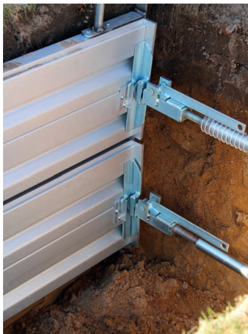
AB Orax stämplingslämmar av aluminium och gravstämp med frigöring. Foto: AB Orax
