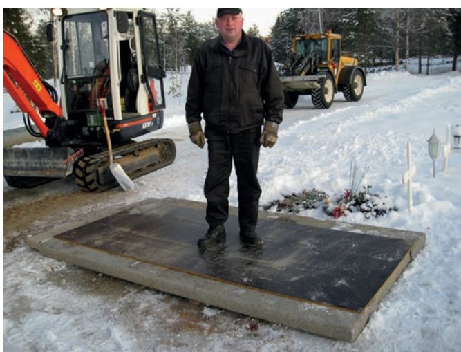
Efter grävningen täcks gravöppningen av en tättslutande skiva med hög hållfasthet för att förhindra olyckor.
