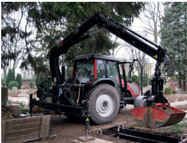
Grävning och återfyllning genomförs med en Hiab-kran monterad på ett traktorchassi.
