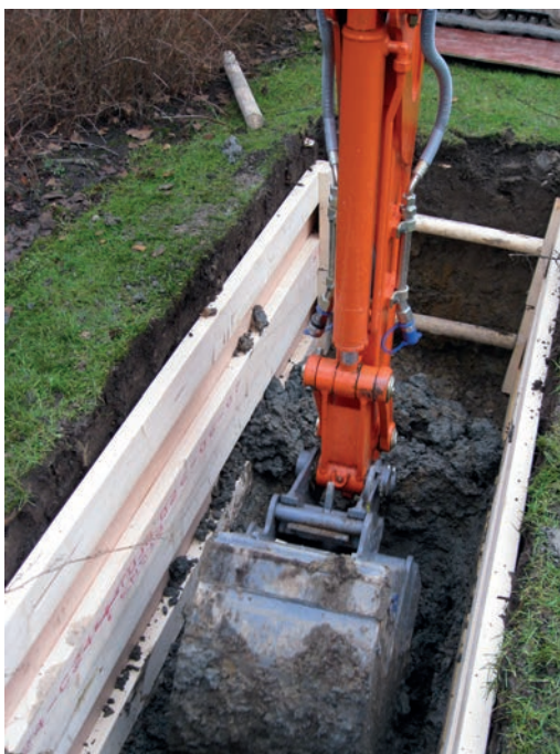
Besvärlig jord kan behöva engångsrasskydd som kan lämnas kvar i samband med återfyllning.
