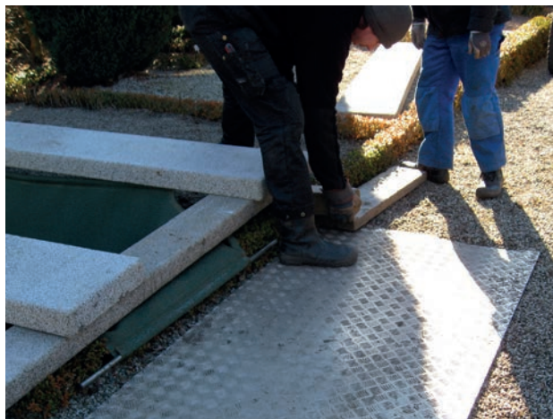
En tryckutjämningskiva närmast graven minskar risken för ras både i samband med grävning och ceremoni.
